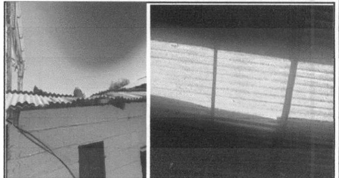
Foto 2: Techo en deteriorado, filtra el agua en las aulas.
